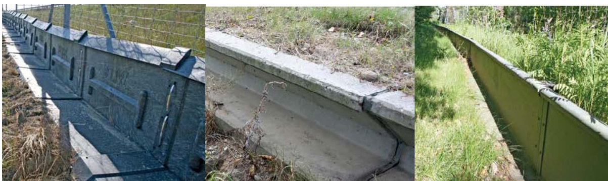
Rysunek 2 Przykład wygradzeń wykonanych z różnych materiałów (tworzywo sztuczne, beton, blacha)[15]
